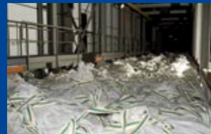
Pierrelatte - aujourd'hui : matériels détruits, déchets prêts pour évacuation
